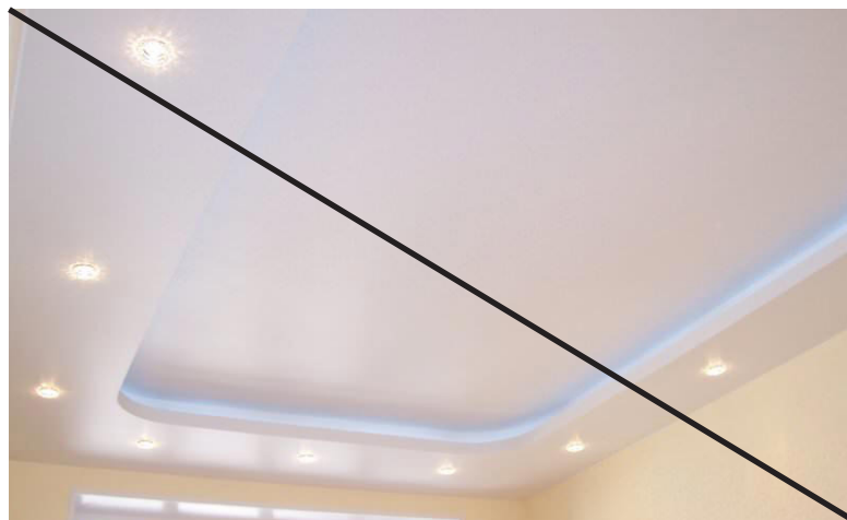
Плохо Многоуровневые гипсокартонные конструкции
